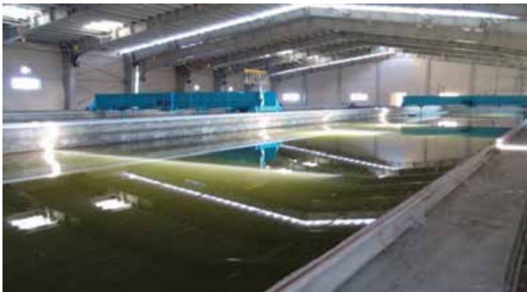
شکل ۴۵-۱- تصفیه خانه آب مشکین شهر
