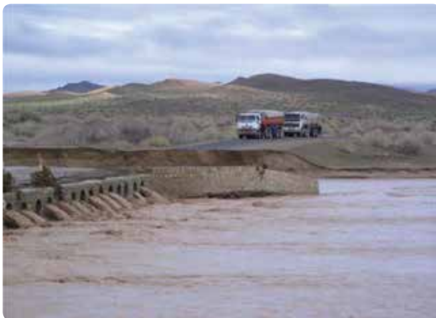
شکل ۴۲-۱- خسارت‌های ناشی از وقوع سیل در شهرستان شاهرود
