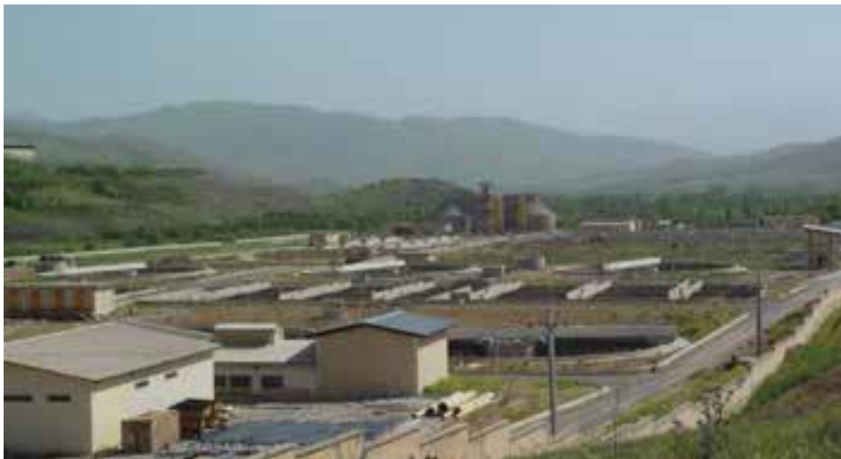
شکل ۷۳-۱- تصفیه‌خانه فاضلاب سنندج
