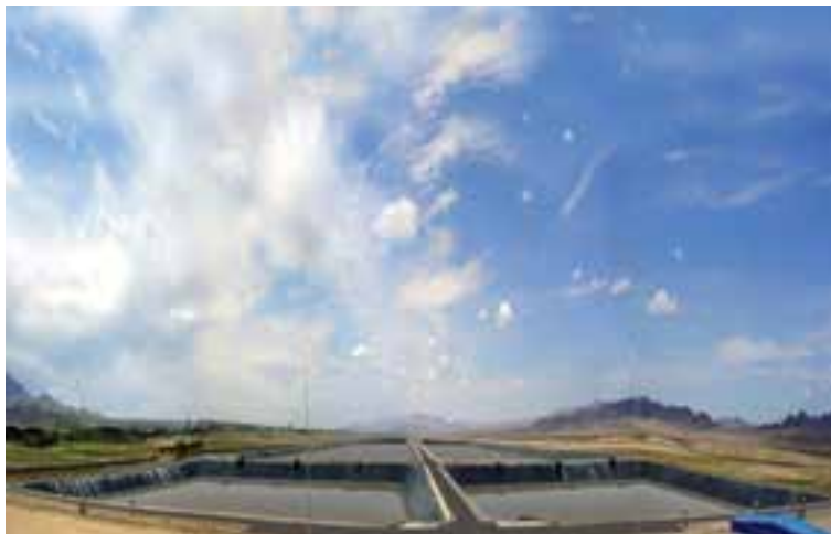
شکل ۱۶-۵- تصفیه‌خانه فاضلاب شهر بیرجند
