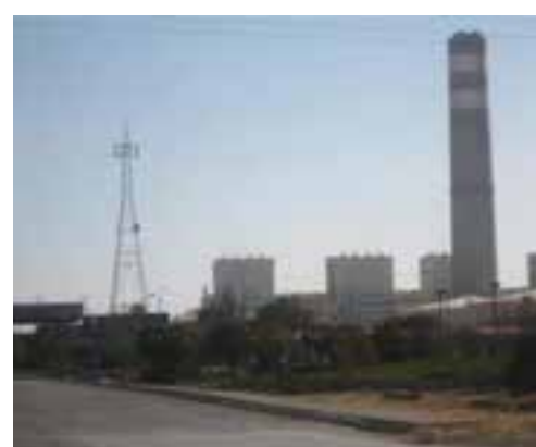
شکل ۱۹-۵- نیروگاه برق شهید مفتاح - فامنین
