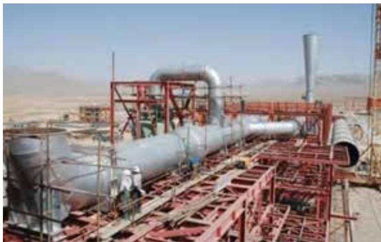
تصویر ۱-۱۵- کارخانه درحال احداث فولاد چهارمحال
