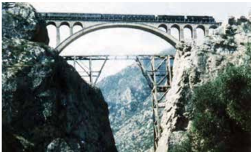
شکل ۲۸-۵- راه آهن شمال - پل ورسک
