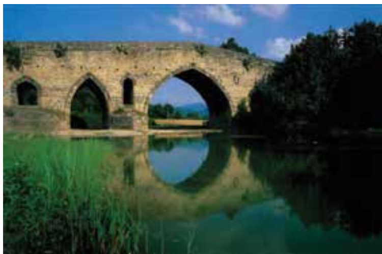
شکل ۲-۵- پل شاهپور در شیرگاه
