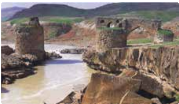
شکل ۲۹-۵- پل گاومیشان دره شهر
