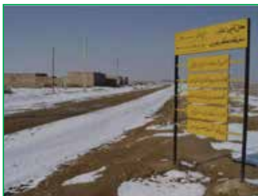
شکل ۶-۶- پروژه احداث راه روستایی - آق تپه
