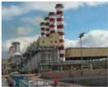
نیروگاه سیکل ترکیبی قم
