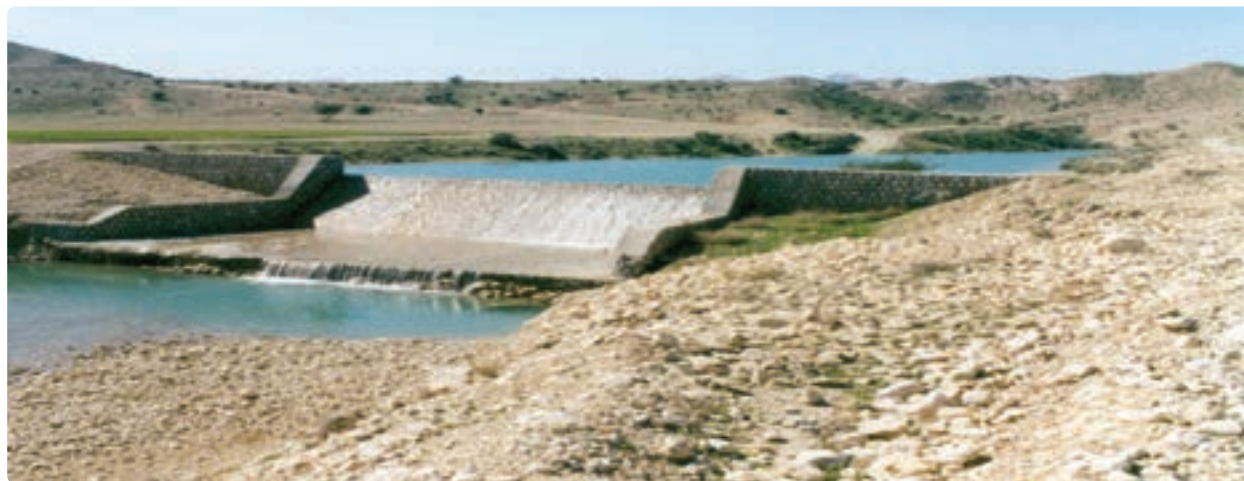
شکل ۱۳-۱۴- احداث استخرهای ذخیره آب
