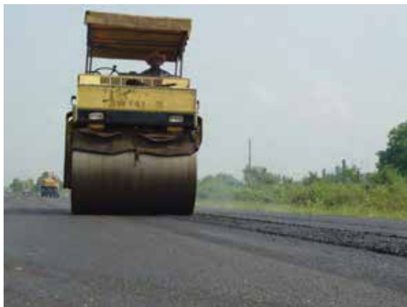
شکل ۴-۶- عملیات راه سازی
