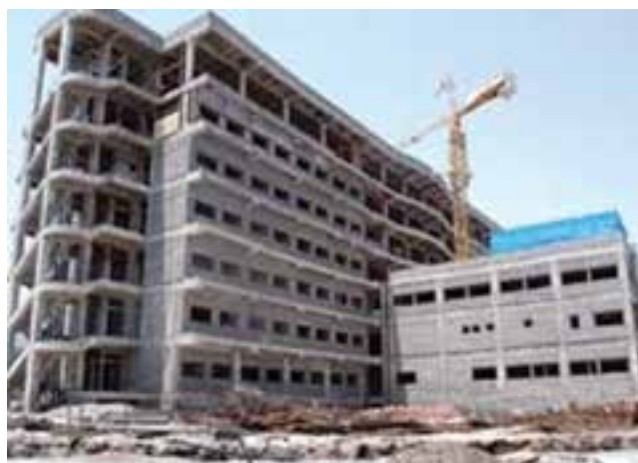
شکل ۱۰-۱۴- عملیات ساخت بیمارستان ۲۰۰ تختخوابی امام رضا(ع)
