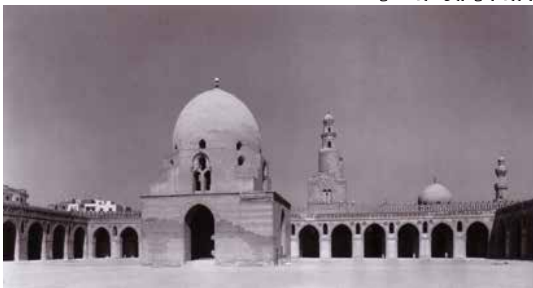
۱۰-۷- مسجد ابن طولون ، فسطاط ، نمای کلی ، ۲۶۶ هجری
