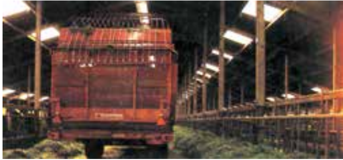
شکل ۶-۳ نمای پنجره‌های سقفی در اصطبل
