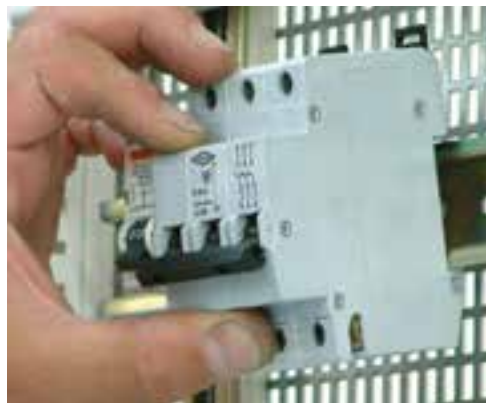
شکل ۹-۲- طرز قرارگیری فیوز مینیاتوری روی ریل
