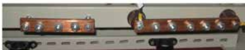
شکل ۱۶-۳ اتصال پیچی
