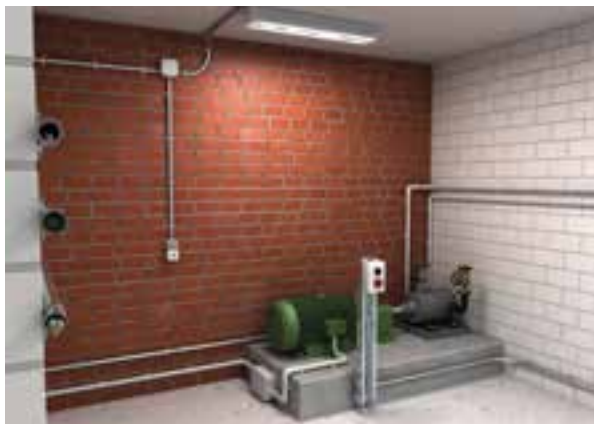
شکل ۶۹-۳ مدار الکتریکی لامپ فلورسنت با کلید یک پل
