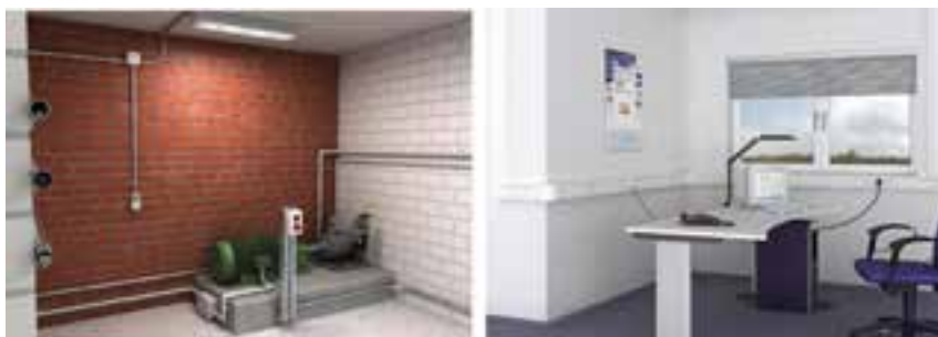
ب- سیم کشی داخل لوله
