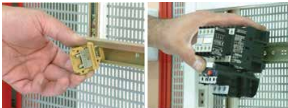
شکل ۵-۶۷ نصب کنتاکتور و ترمینال روی ریل
