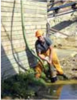
شکل ۲-۳۲- کاربرد پمپ کفکش
