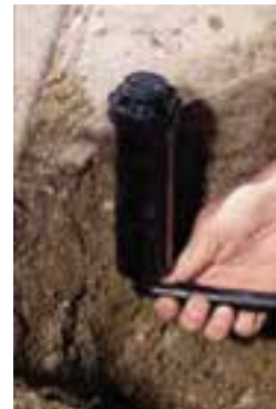
د) نصب آب پاش
