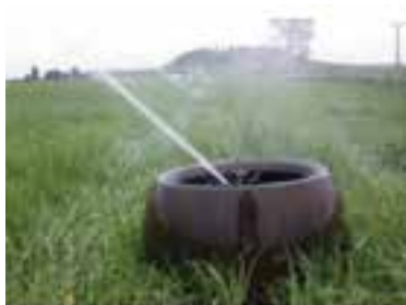
(ج) آب‌پاش نصب شده در حال پاشش
