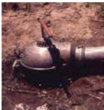
ب) شیر هیدرانت سر لوله زیر زمینی
