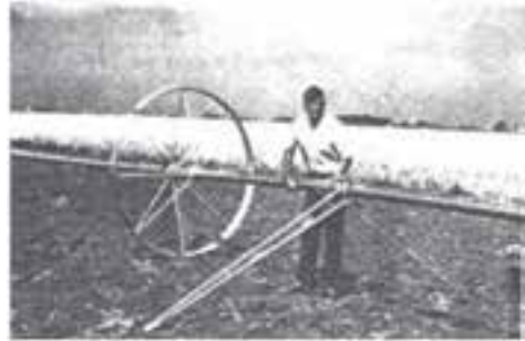
الف) نصب جک تثبیت روی لوله‌ها
