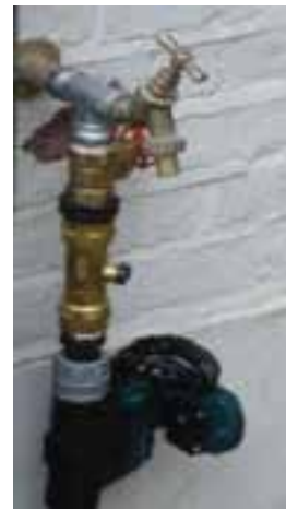
الف) لوله کشی و وسایل جانبی در زیر دریاچه
