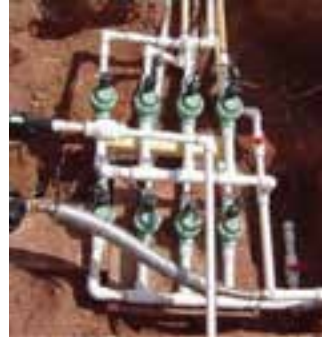
الف) نصب شیرهای برقی در زیر درجه در زمین
