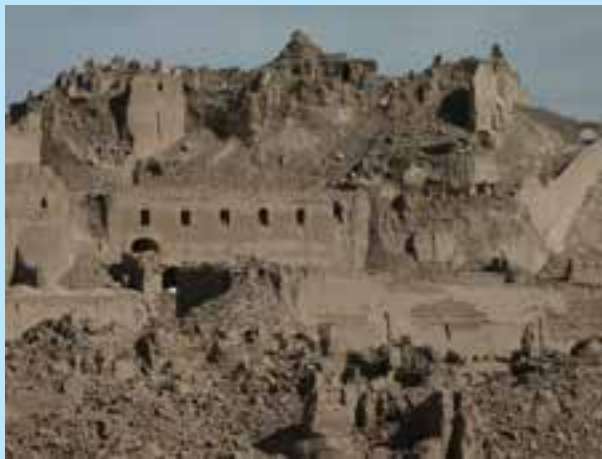
تأثیر زلزله دی‌ماه سال ۸۲ بم بر بناهای کهن و جدید شهر تصویر پایین ارگ تاریخی بم بزرگ‌ترین بنای خشتی جهان و تصویر بالا ساختمانی جدید با اسکلت فلزی
