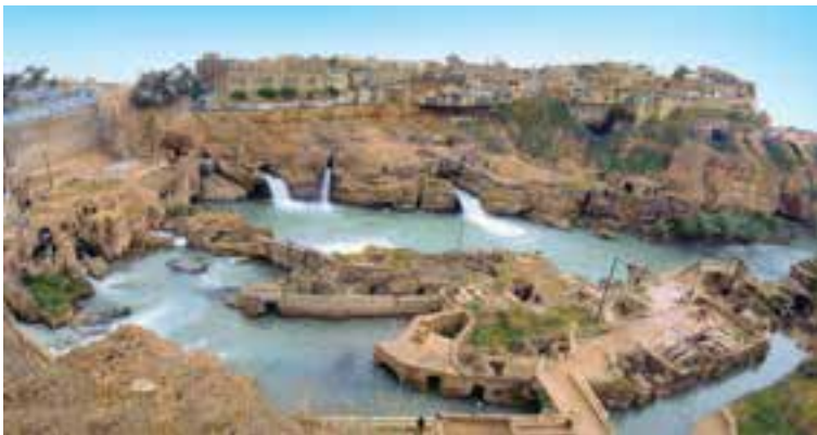
۴-۷- آسیاب‌های شوستر مربوط به عهد ساسانی که با استفاده از ساروج و ملات شفته آهکی ساخته شده است.
