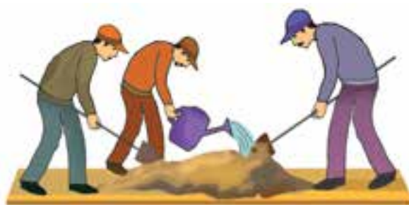
شکل ۳-۷- سرن‌کردن ماسه و مخلوط کردن ملات
