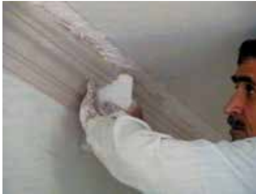
شکل ۸-۳- نحوه‌ی اجرای ابزار گچی (گلویی) در محل اتصال سقف و دیوار
