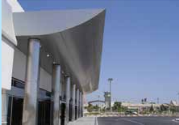
کاربرد ورق‌های کمپوزیت آلومینیومی در نمای بیرونی فرودگاه کیش
