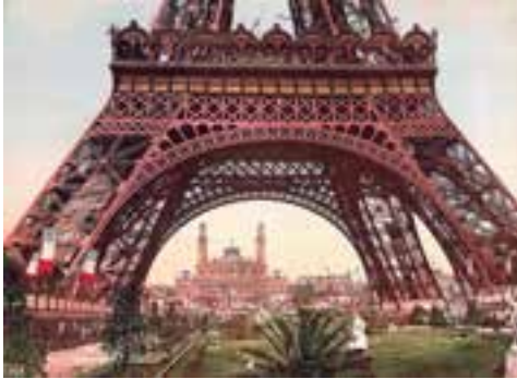
شکل ۲-۱۰- برج ایفل در حال ساخت - پاریس ۱۸۸۹ میلادی
