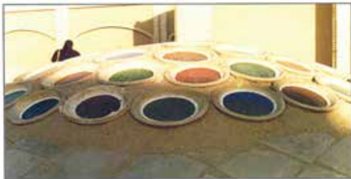
شکل ۲-۱۲- استفاده از گلجام در بازسازی سقف حمام
