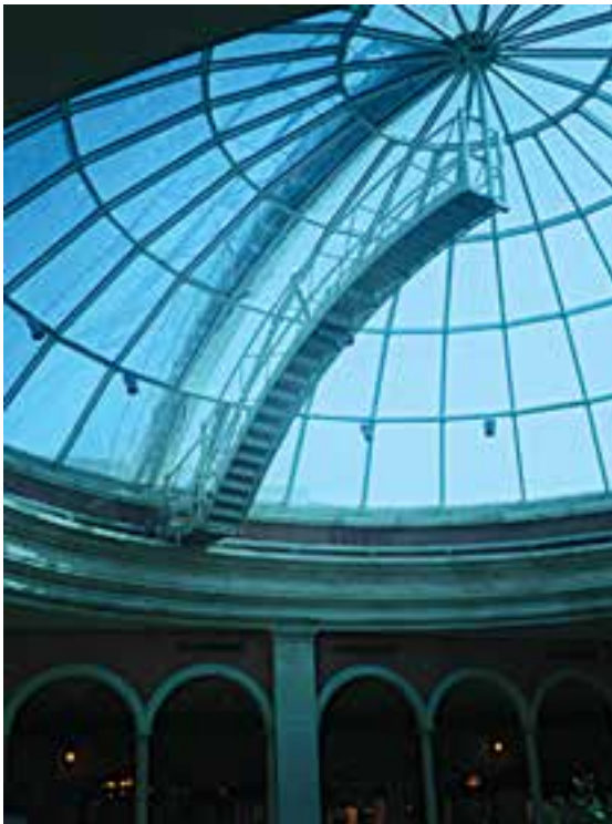
شکل ۱-۱۴- استفاده‌ی پلکسی‌گلاس برای پوشش‌های سبک و نور گذران
