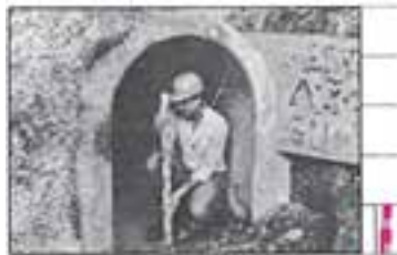
شکل ۱۴-۸- طریقه‌ی نگاه داشتن میر
