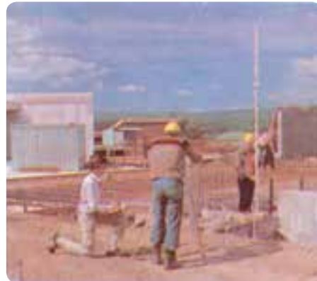
شکل ۱۴-۸- طریقه‌ی نگاه داشتن میر
