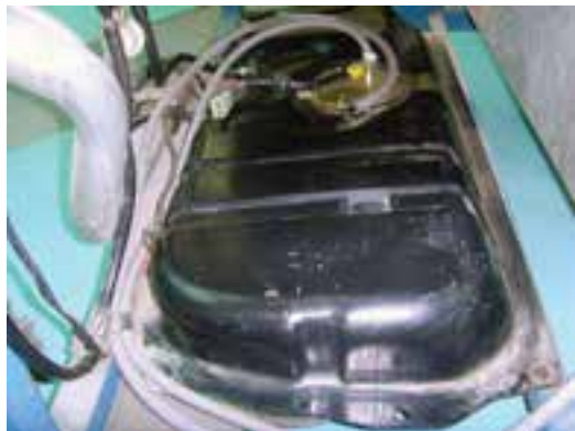
شکل ۱-۲۷ مخزن نصب شده و آماده سوخت گیری
