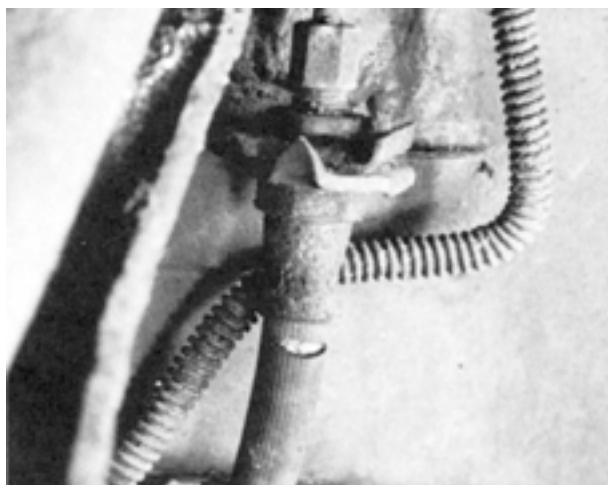
شکل ۱-۶۹- کنترل لوله‌ها و اتصالات
