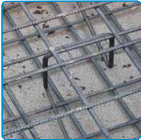
شکل ۳-۵۳- استفاده از خرک در میلگرد گذاری پی
