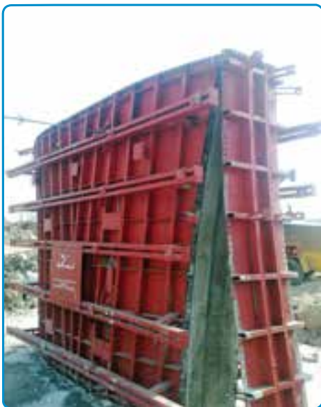
شکل ۳-۴۲- قالب برداری
