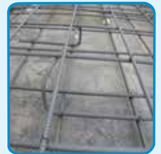
شکل ۳-۵۵- استفاده از خرک در میلگرد گذاری دال
