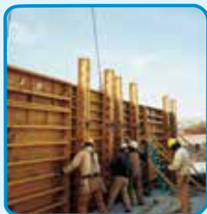
شکل ۳-۳۶- قالب فایبر گلاس برای اجرای دیوار بتنی
