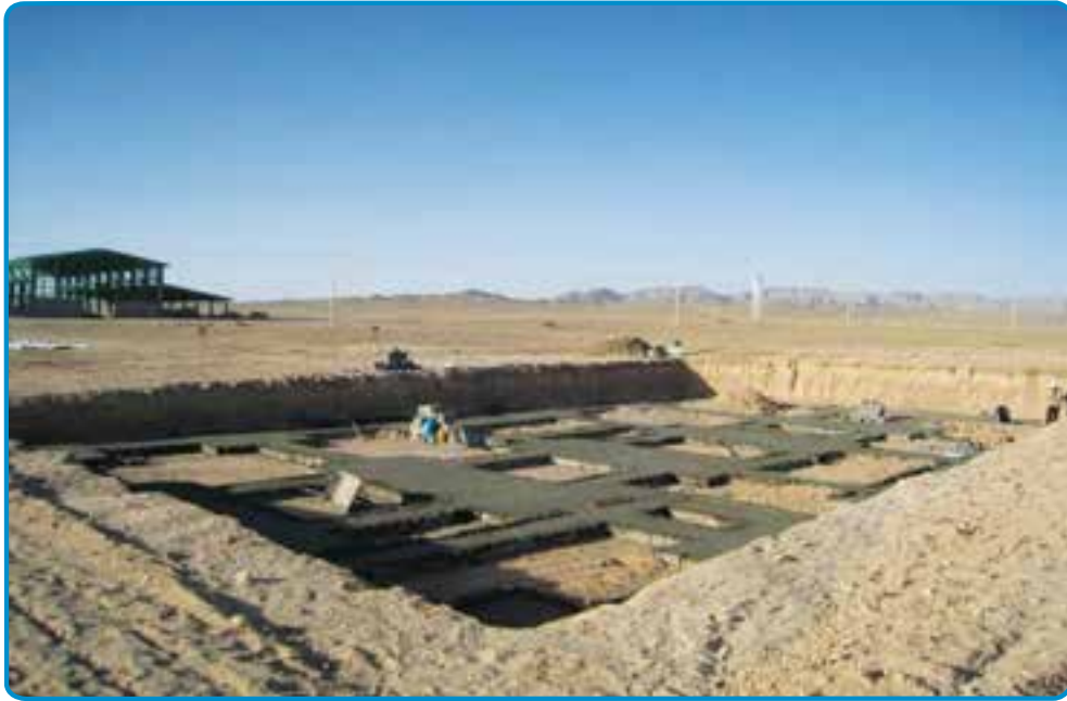
شکل ۳-۶- گودبرداری در زمین‌های نامحدود
