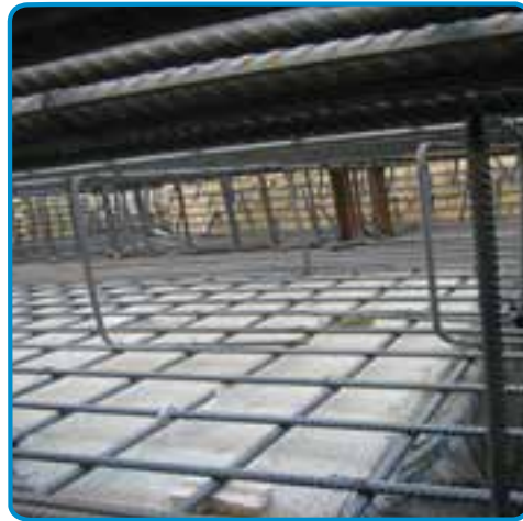
شکل ۳-۵۳- استفاده از خرک در میلگرد گذاری پی
