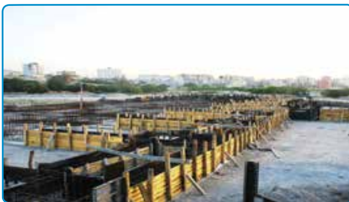
شکل ۳-۲۷- قالب چوبی برای اجرای پی
