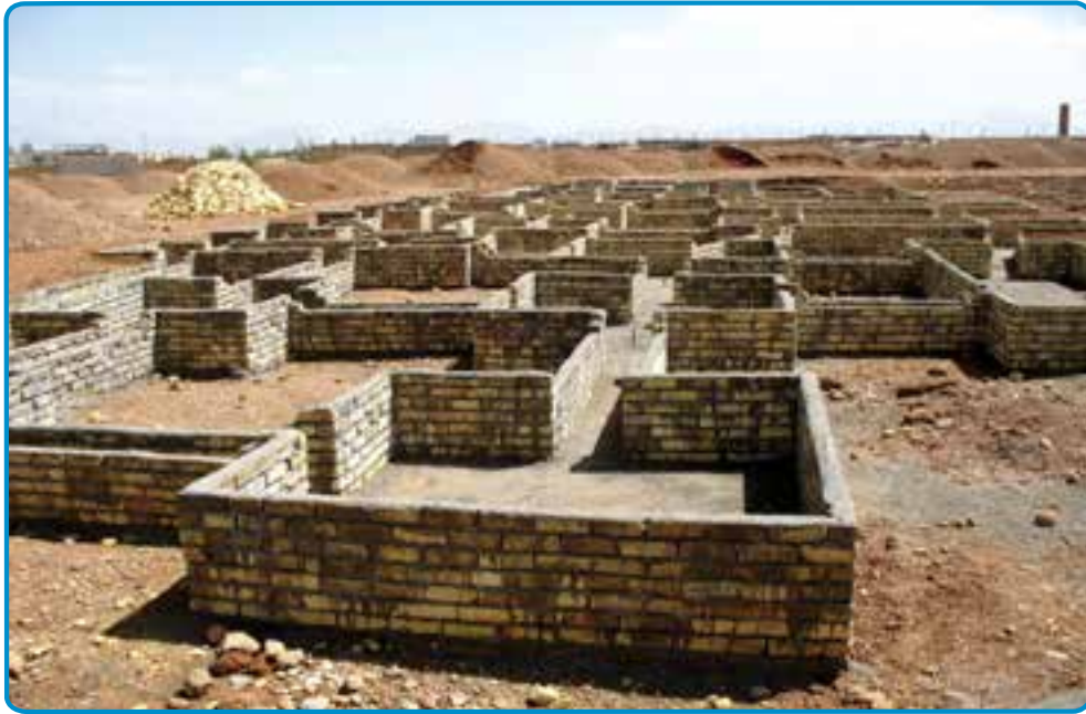
شکل ۱۵-۳- استفاده از قالب آجری برای اجرای پی
