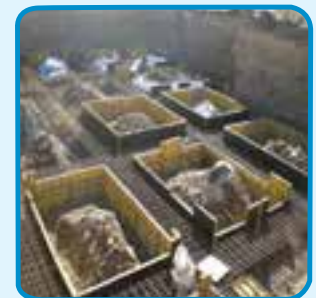
شکل ۳-۳۱- قالب فایبرگلاس برای اجرای پی
