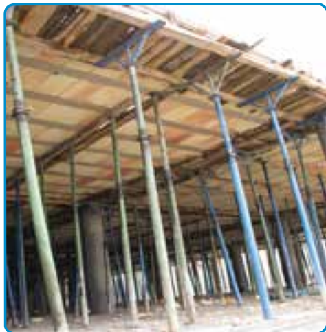
شکل ۲۱-۳- استفاده از شمع‌های فلزی جهت نگهداری قالب‌ها
