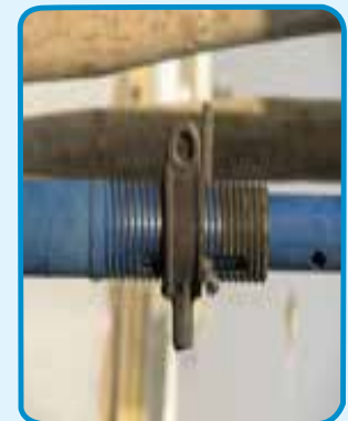
شکل ۲۳-۳- سوراخ‌های روی شمع فلزی جهت تعیین ارتفاع مناسب
