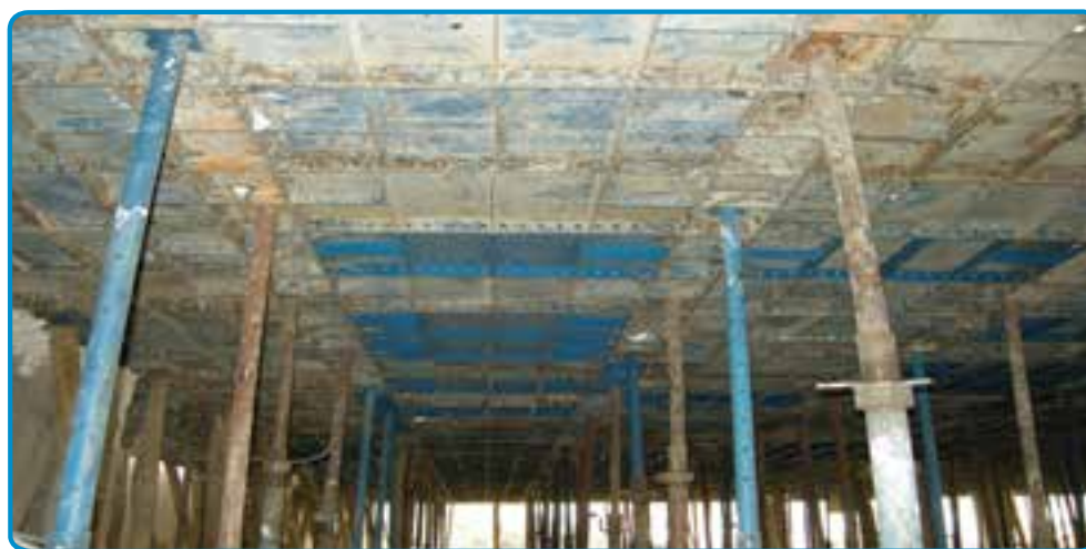
شکل ۳-۳۸- استفاده از قالب فلزی برای اجرای دال بتنی
