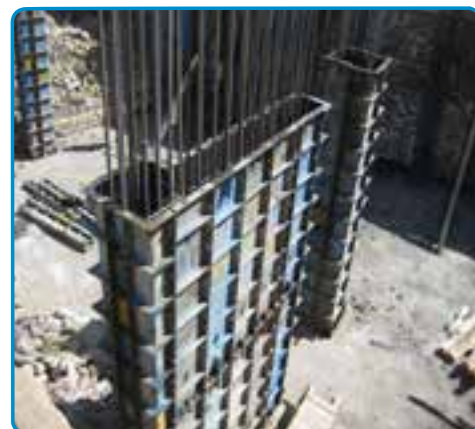
شکل ۳-۳۵- قالب فلزی برای اجرای دیوار بتنی
