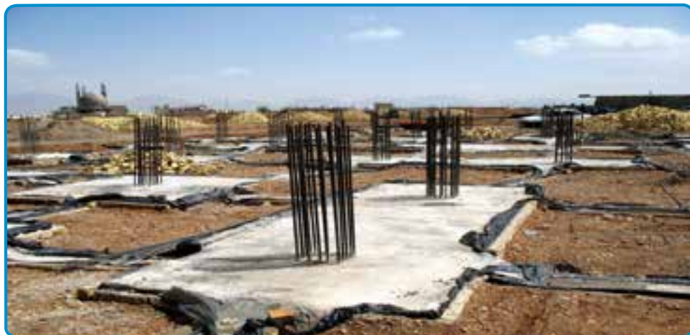
شکل ۱۰-۳- استفاده از پلاستیک در پی
