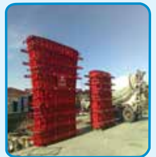
شکل ۱۷-۳- استفاده از قالب فلزی برای اجرای پایه پل
