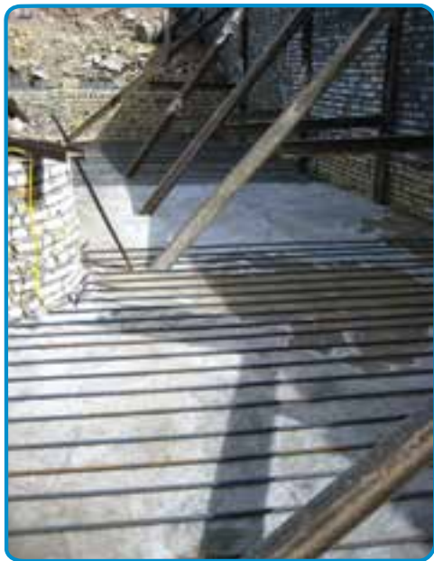
شکل ۳-۴۶- میلگرد طولی کف پی
