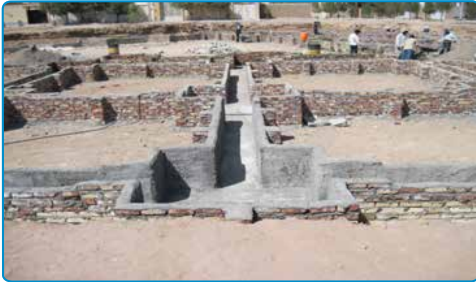
شکل ۳-۲۹- قالب آجری برای اجرای پی
