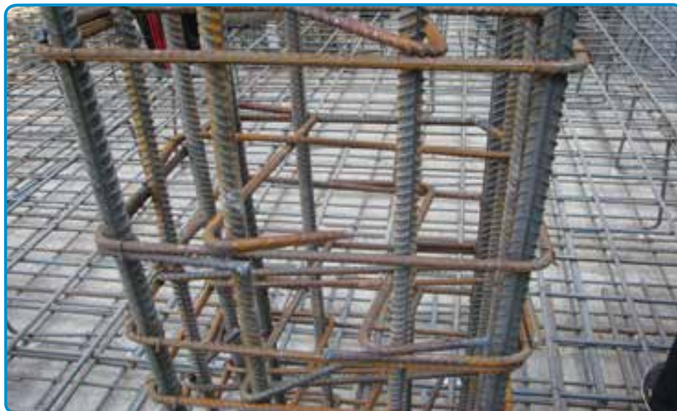
شکل ۵۰-۳- کاربرد سنجاقک در میلگرد گذاری ستون
