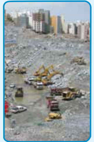
شکل ۳-۷- گودبرداری در زمین‌های نامحدود
