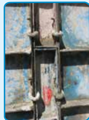
شکل ۱۳-۳- پشت بند قالب
