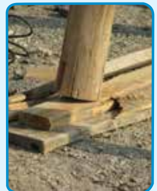
شکل ۲۵-۳- استفاده از گوه جهت تنظیم ارتفاع
