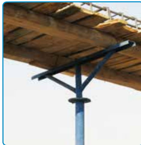
شکل ۲۱-۳- استفاده از شمع‌های فلزی جهت نگهداری قالب‌ها
