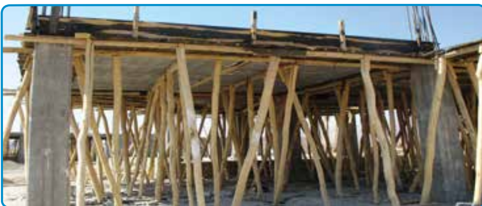
شکل ۲۴-۳- استفاده از شمع‌های چوبی جهت نگهداری قالب‌ها
