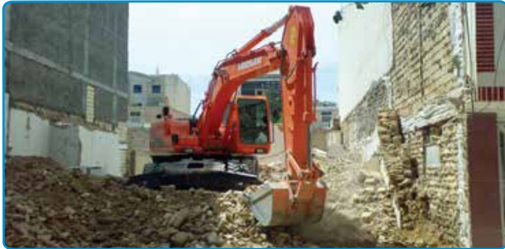
شکل ۳-۲- خاکبرداری با ماشین
