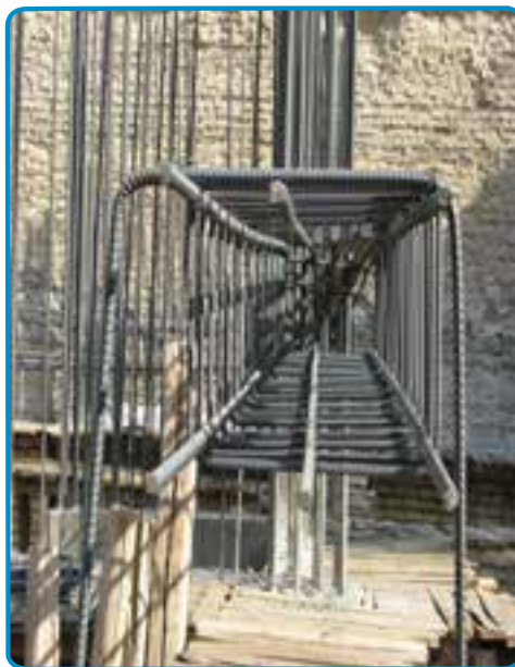
شکل ۳-۴۵- میلگرد طولی در تیر
