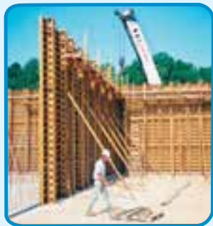
شکل ۱۹-۳- اجرای دیوار بتنی فایبر گلاس برای
