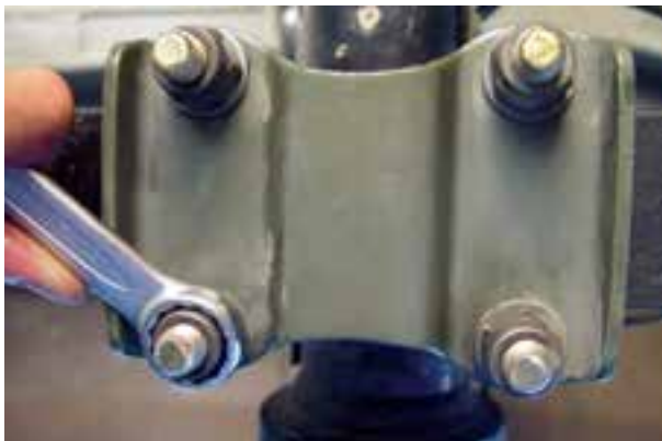
شکل ۳-۶۶- باز کردن مهره‌های کرپی‌ها (پیچ‌های U شکل)
