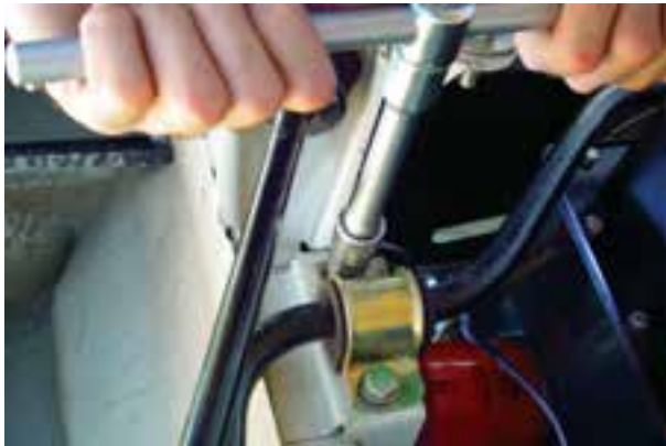
شکل ۳-۸۶- باز کردن میله ضد غلتش (موج گیر)
