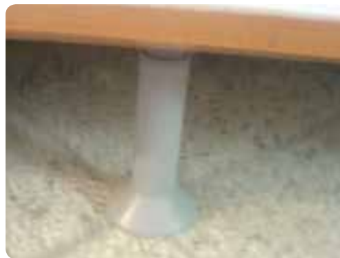
شکل ۶-۶۴ پایه نصب شده در زیر کابینت
