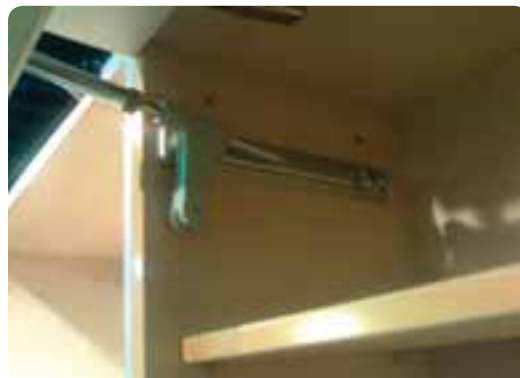
شکل ۶-۳۷ در کابینت نصب شده با نگهدارنده پمپی
