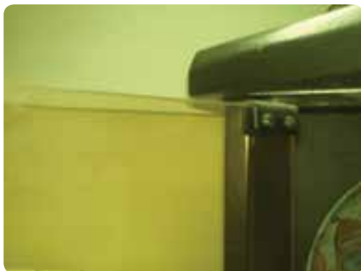
شکل ۶-۴۰ در شیشه ای با لولای پاشنه ای
