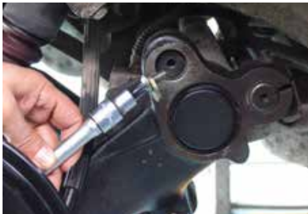
شکل ۱۷۶-۳- نصب واشر فشار و بیج‌های انتهای میله‌ها
