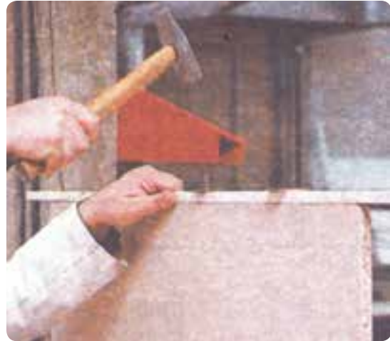
شکل ۷۸-۶ نصب زهوار چوبی لبه چسبان
