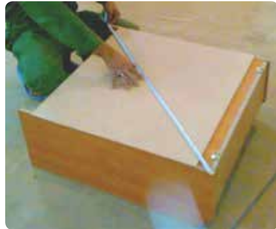
شکل ۱۳۰-۶ کنترل دويدگی کابینت
