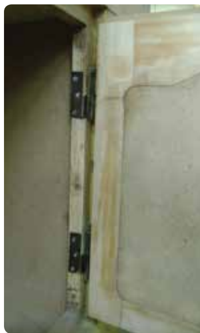
شکل ۶-۸۸ در قاب تنکه‌ای با لولای قابل‌مهای
