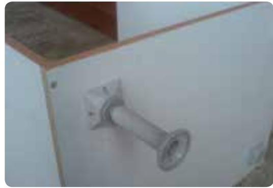
شکل ۶-۱۱۵ پایه نصب شده زیر کابینت
