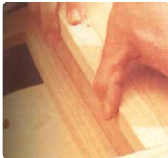
شکل ۶-۱۵۶ نصب ریل هدایت کشو
