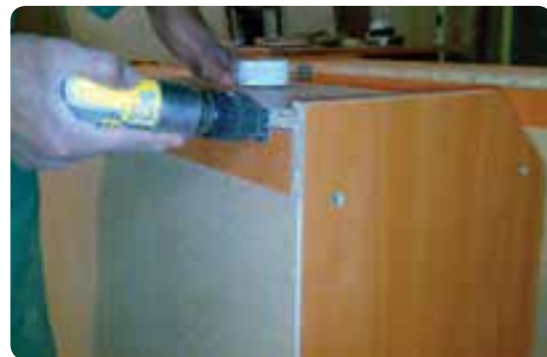
شکل ۱۳۱-۶ نصب لولای محفظه جاواکسی
