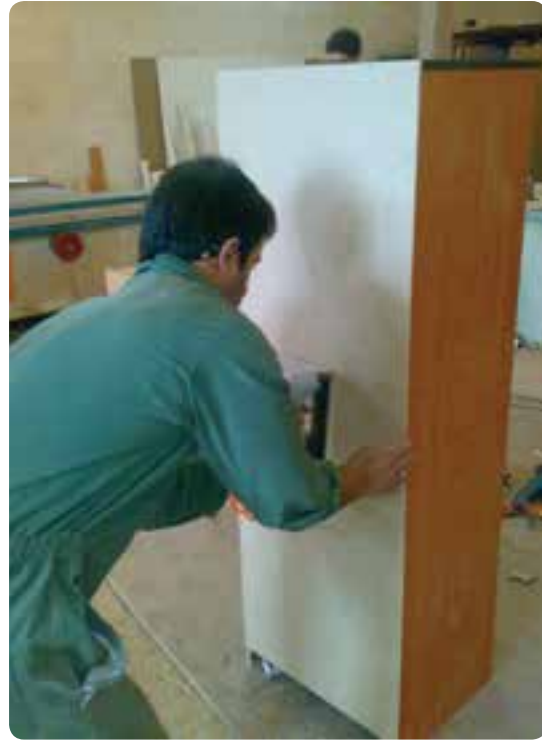
شکل ۱۲۱-۶ نصب پشت بند کابینت
