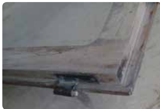
شکل ۶-۹۱ نصب لولای قابل‌ه‌ای در دو راهه در
