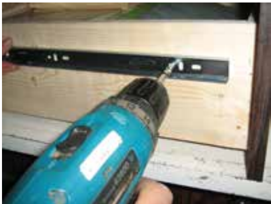
شکل ۷-۳۶ نصب ریل بر روی بدنه‌ی کشو
