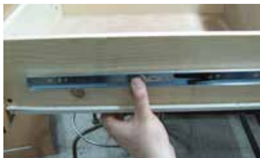
شکل ۷-۳۵ تعیین محل ریل بر روی بدنه کشو
