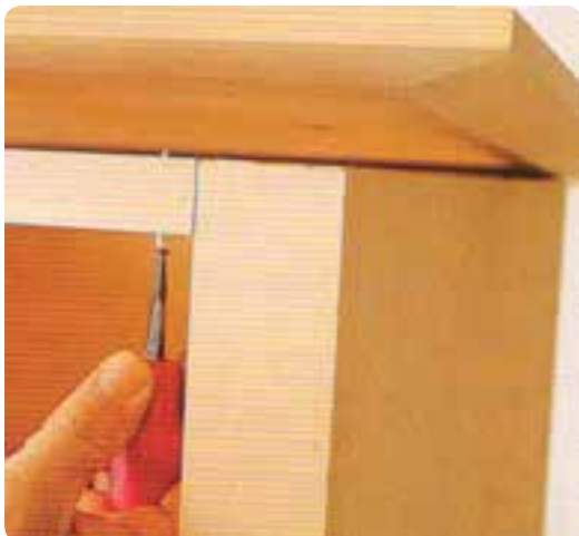
شکل ۶۹-۸ بستن صفحه روی کابینت
