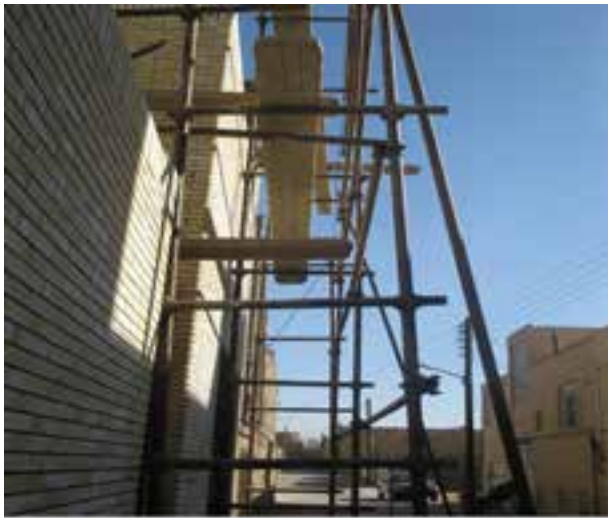
شکل ۱-۱: داربست فلزی برای چیدن دیوار
