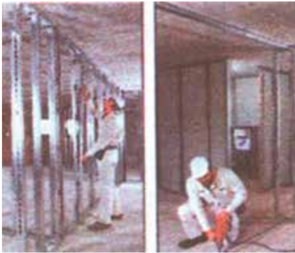
شکل ۱- ۴۴: قاب سازی جهت اتصال روکش های گچی
