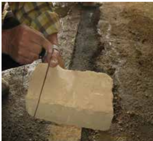
شکل ۱-۷۲: نحوه بستن ریسمان کار به آجر
