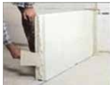
شکل ۱ - ۳۶: طریقه نصب بلوک های گچی
