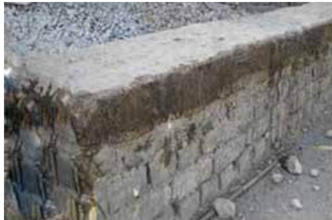
شکل ۱-۲۹: کرسی چینی یا عایق کاری رطوبتی
