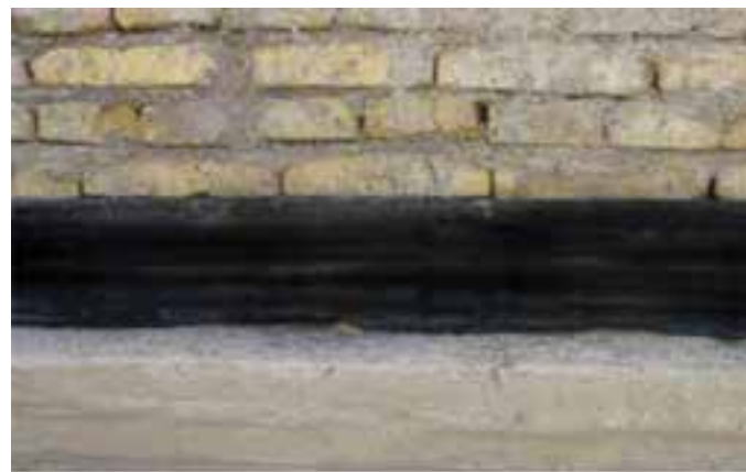
شکل ۱-۳۰: دیوار روی کرسی چینی
