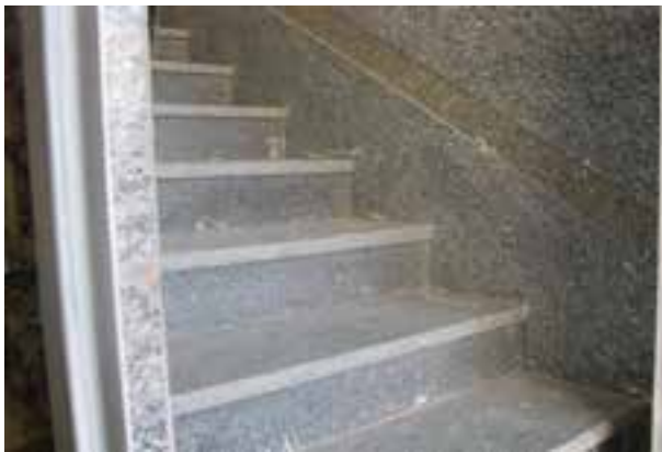
شکل ۱-۱۶ : کاربرد سنگ در نمای ساختمان
