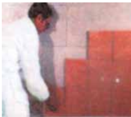
شکل ۱ - ۴۳: نصب کاشی روی قطعات پیش ساخته گچی
