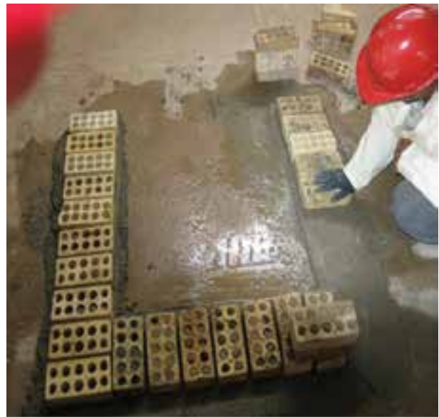
شکل ۱ - ۳۳ (ج): ریسمان کشی و چیدن ضلع سوم
