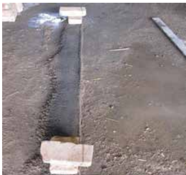
شکل ۱- ۹۰: بادخور نمودن ریسمان کار
