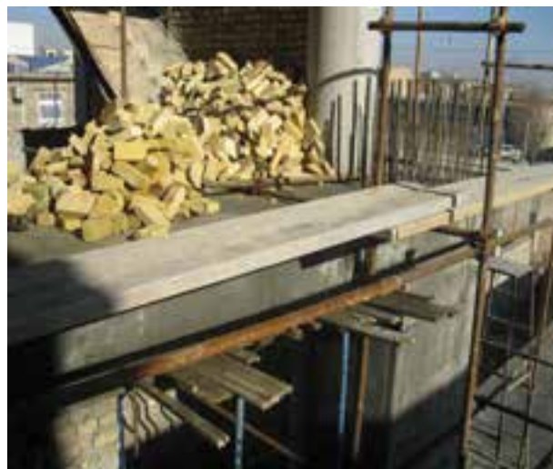
شکل ۱-۲: ضخامت مناسب برای تخته زیر پای
