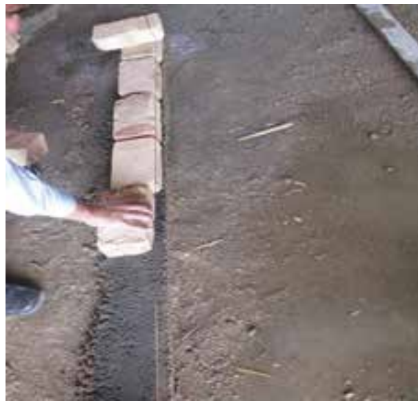
شکل ۱-۹۱: نحوه چیدن آجر در امتداد ریسمان کار
