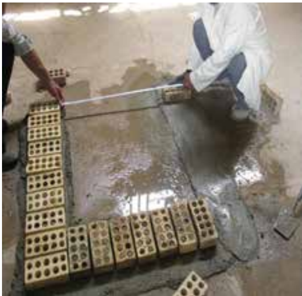
شکل ۱ - ۳۳ (ب): جدا کردن اندازه دو طرف دیگر
