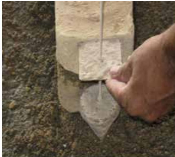
شکل ۱- ۷۷: شاقول کردن نبش کار
