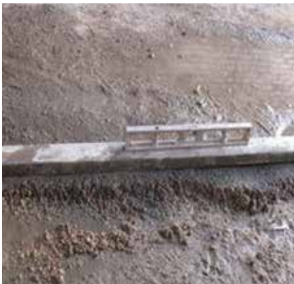
شکل ۱ - ۸۶: کنترل تراز سطح ملات
