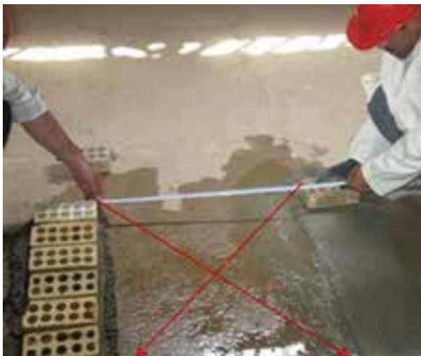
شکل ۱ - ۳۳ (ب): جدا کردن اندازه دو طرف دیگر
