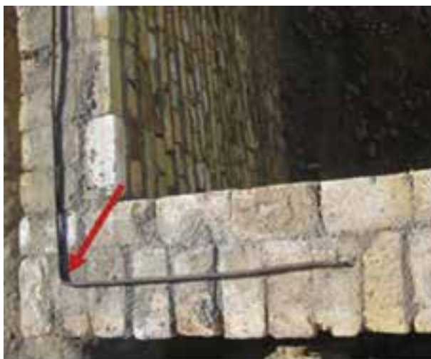
شکل ۱ - ۵۵: میلگرد گذاری در محل اتصال دو دیوار
