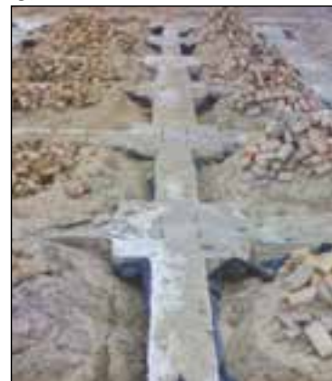
شکل ۳-۱۳۷ پی و شناژ بعد از بتن‌ریزی
