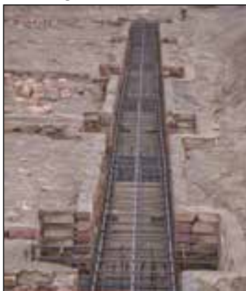
شکل ۳-۱۳۶ پی و شناژ قبل از بتن‌ریزی
