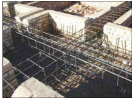
شکل ۳-۱۳۵ عبور میلگردهای شناژ در پی
