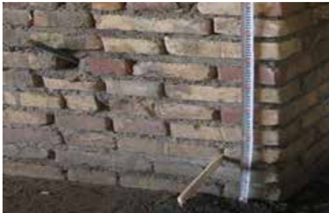
شکل ۳-۳۳: جدا کردن خط تراز روی دیوار
