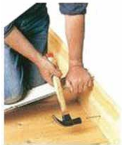
شکل ۳- ۲۹: نصب قرنیز چوبی با میخ
