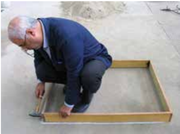
شکل ۳-۲- قالب‌بندی فونداسیون
