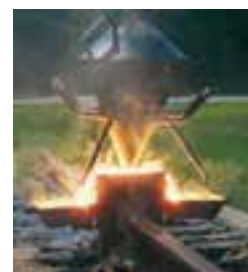
از واکنش ترمیت برای جوش دادن خطوط راه‌آهن استفاده می‌شود.
