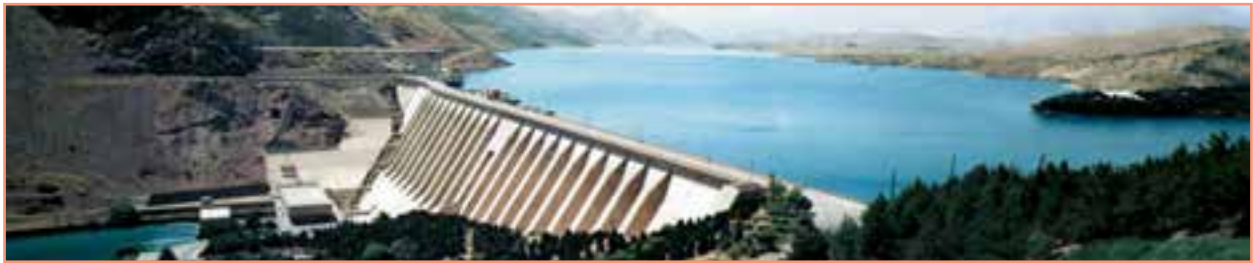
شکل ۲۸-۶- احداث سد روشی برای کاهش خطر خشک‌سالی
