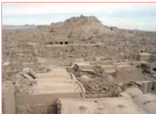
ب) ارگ بم بعد از وقوع زلزله
