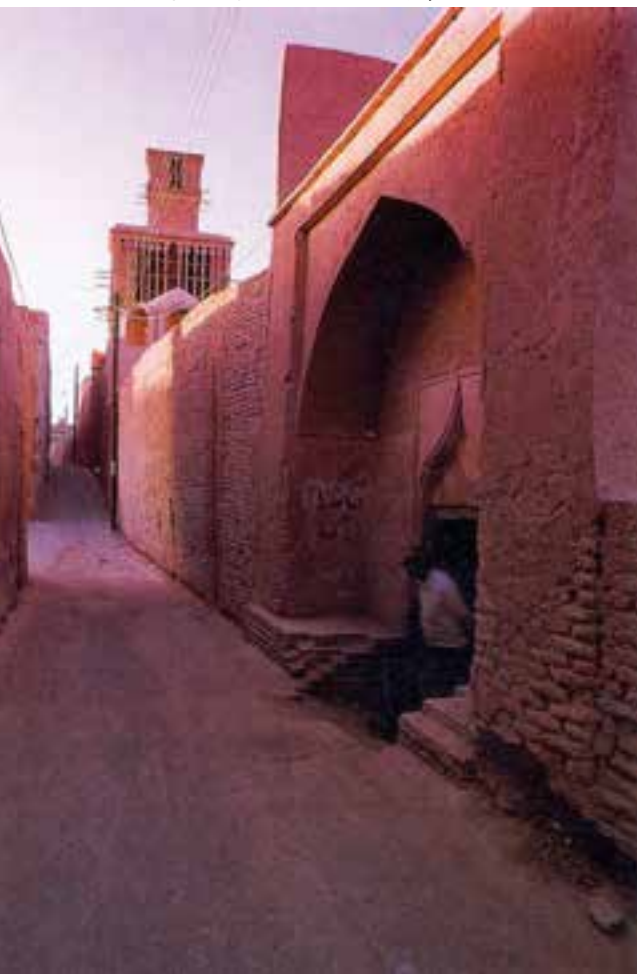
تصویر ۹-۵- نمای بیرونی فاقد پنجره
