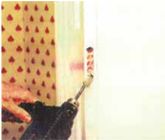
شکل ۱۰-۴۵- تفلیهی محل قفل با دریل.
