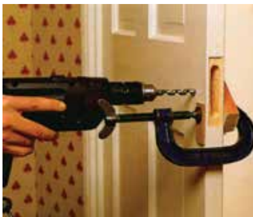
شکل ۱۰-۴۸- سوراخ‌کاری ممل پلاک و دستگیره‌ی قفل.
