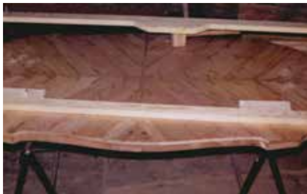
شکل ۱۱-۳۲- کلاف آماده شده برای شبکه‌ریزی.
