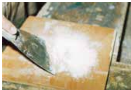
شکل ۴-۱۲- پودر مل و سریش را مخلوط کرده، در وسط تخته بتونه جمع کنید.
