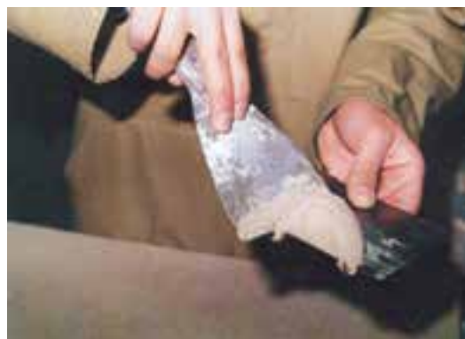
شکل ۸-۴- کاربرد لیسه و کاردک هنگام بتونه کاری.
