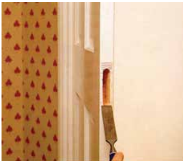
شکل ۱۰-۴۶- درآوردن محل کامل قفل.
