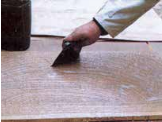
شکل ۱۴-۶- چسب را به وسیله‌ی شانه، روی صفحه‌ی مصنوعی پخش کنید.
