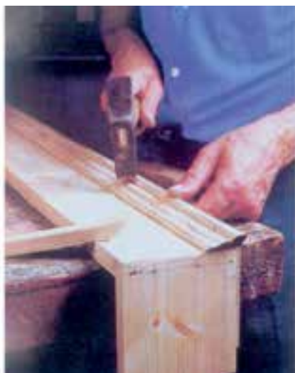
شکل ۱۰-۱۳- نصب زهوار با میغ.
