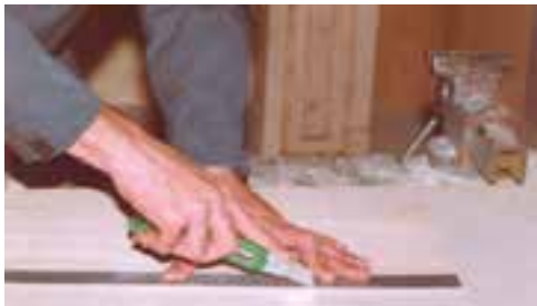
شکل ۵-۲۹- برش (روکش با کاتر)
