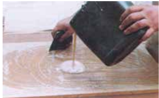
شکل ۶-۶. پخش کردن چسب به وسیله‌ی شانه‌ی چسب‌زنی.
