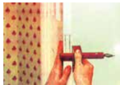
شکل ۱۰-۴۳- فلکشی محل قفل با فلکش تیره‌دار.
