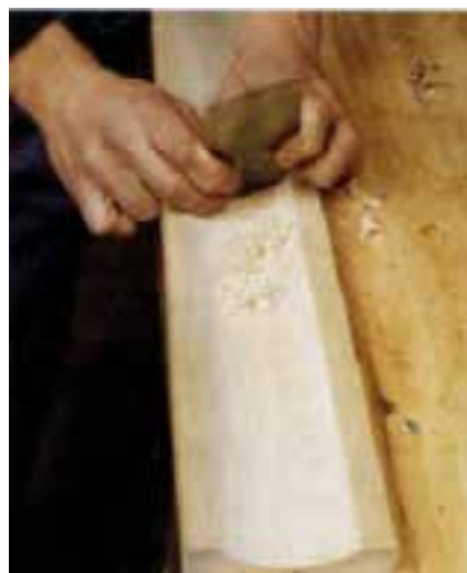
شکل ۲-۵- کاربرد لیسه با لبه‌ی نیم گرد.
