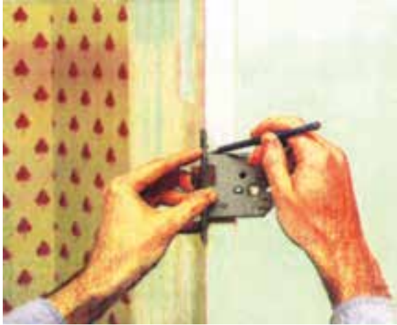
شکل ۱۰-۴۴- فلکشی محل قفل روی در کار.
