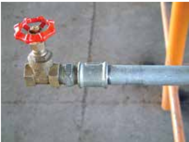
شکل ۴-۸- اتصال دنده‌ای
