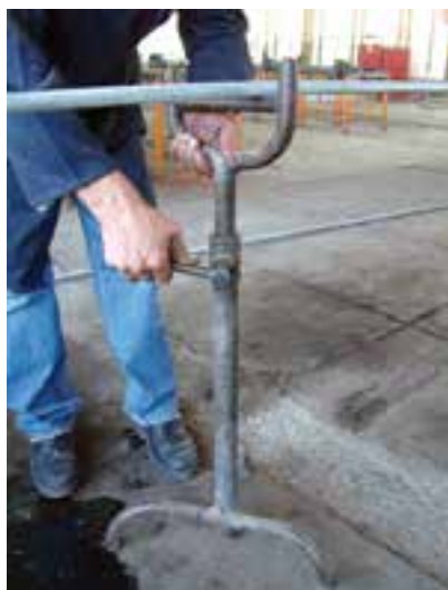
شکل ۴-۷۶- طرز تنظیم خرک به زیر لوله
