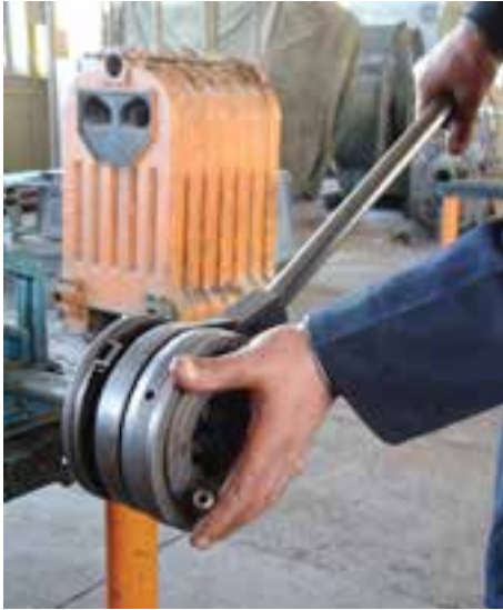
شکل ۴-۶۶- درگیر کردن حدیده با سر لوله
