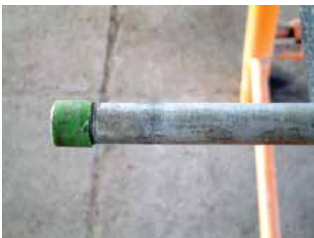
شکل ۱۶-۴ اتصال بوشن پلاستیکی به سردنده‌ی لوله
