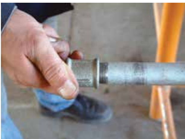
شکل ۴۱-۴ کنترل بار سردنده به وسیله‌ی یک فیتینگ
