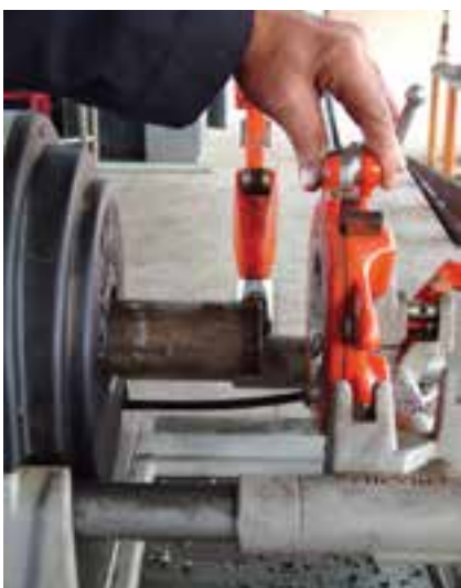
شکل ۴-۹۴- قرار دادن لوله در درون دستگاه و گذاردن تنه‌ی حدیده در محل خود
