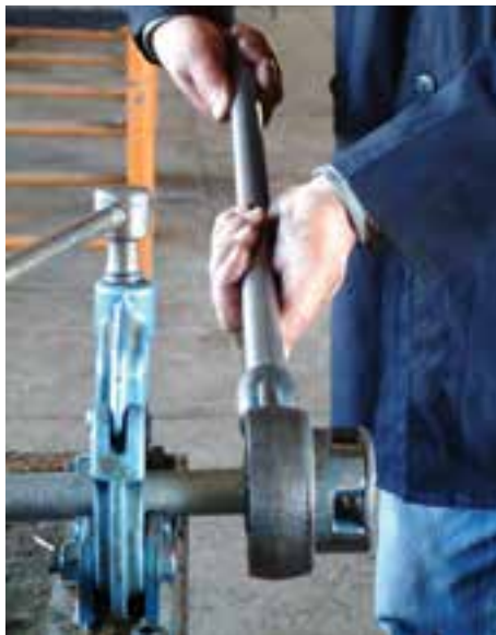
شکل ۴-۵۰- باز کردن حدیده از لوله
