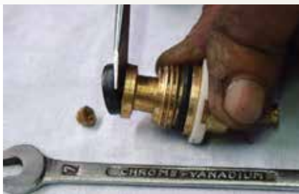
شکل ۲-۶۳- تعویض واشر
