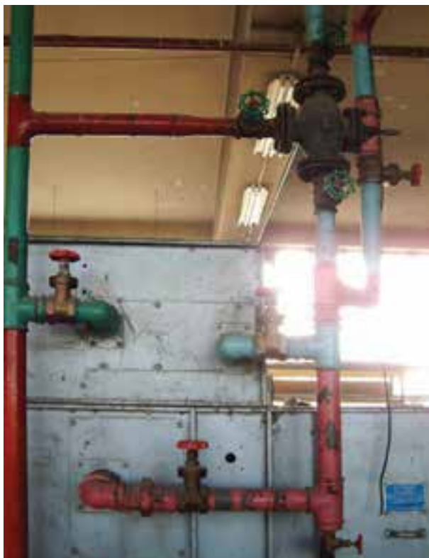
شکل ۲-۸۳ – مورد استفاده‌ی شیر فلکه در تهویه‌ی مطبوع
