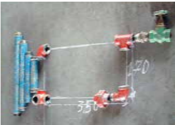
شکل ۵-۱۱۳- بریدن و حدیده کردن لوله‌ها
