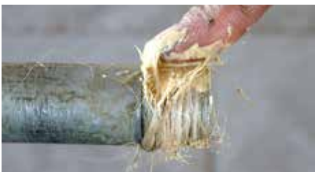
شکل ۵-۵۷- مالیدن خمیر آب بندی بر روی کنف
