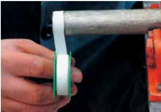
شکل ۵-۵۸- نحوه‌ی پیچیدن نوار تفلون بر روی سردنده
