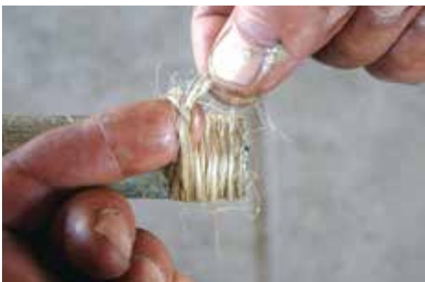
شکل ۵-۵۵- گره زدن انتهای پیچیدن کنف
