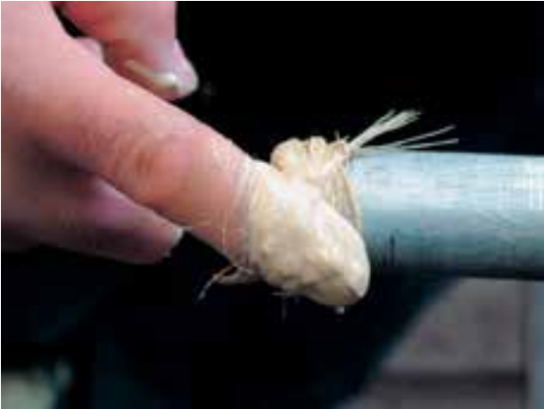
شکل ۵-۹۰- خمیر و کنف کردن سردنده
