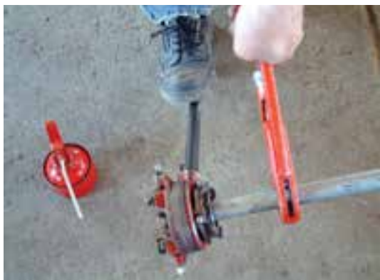
شکل ۱۲۰-۵- عمل حدیده کاری لوله
