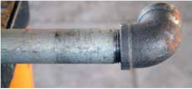
شکل ۵-۹۹- سفت کردن مناسب فیتینگ به لوله
