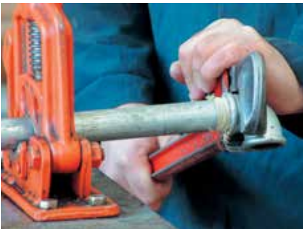
شکل ۵-۹۲- سفت کردن فیتینگ به وسیله‌ی آچار لوله‌گیر
