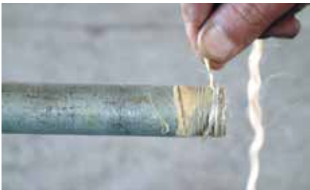
شکل ۵-۵۴- پیچیدن کنف بر روی سردنده
