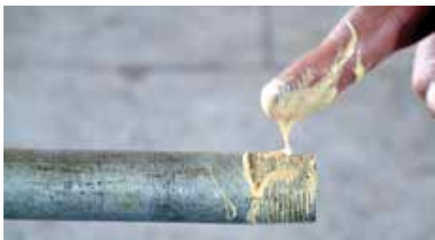
شکل ۵-۵۳- مالیدن خمیر بر روی سردنده
