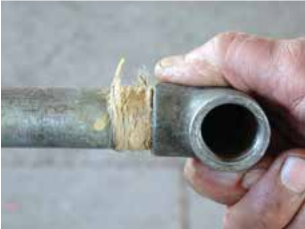
شکل ۵-۹۱- بستن فیتینگ بر روی سردنده
