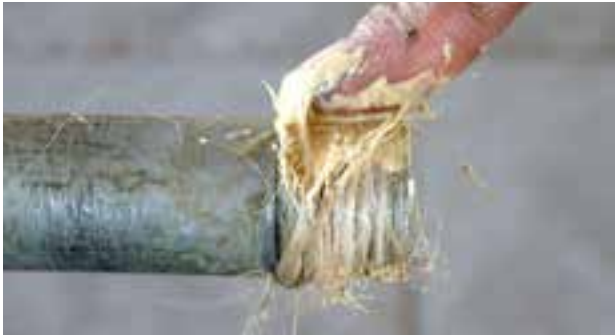
شکل ۵-۱۰۰- استفاده از مواد آب‌بندی
