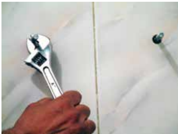
شکل ۳-۴۴- سفت کردن پیچ‌ها در درون رولپلاک‌ها
