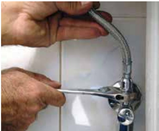
شکل ۳-۴۹ سفت کردن مهره‌های شیلنگ به شیر پیسوار
