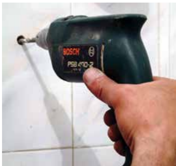
شکل ۳-۴۱ سوراخ کاری محل نصب پیچ‌ها
