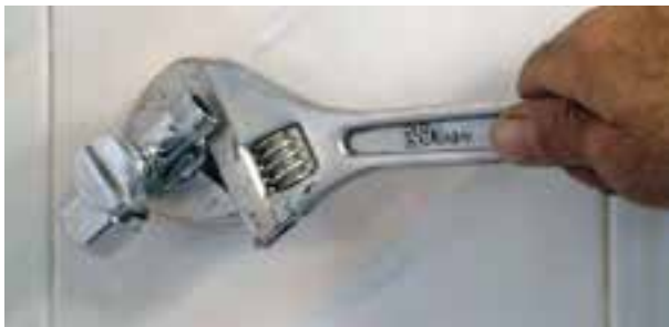
شکل ۳-۴۸ سفت کردن شیر پیسوار با آچار فرانسه
