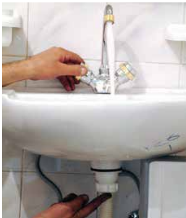
شکل ۳-۵۷- عمل کنترل نشت آب از محل‌های اتصال
