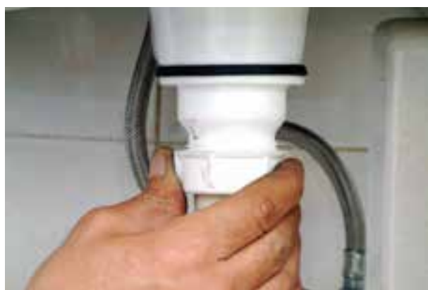
شکل ۳-۵۶- بستن مهره‌ی لوله‌ی عمودی سیفون به زیراب
