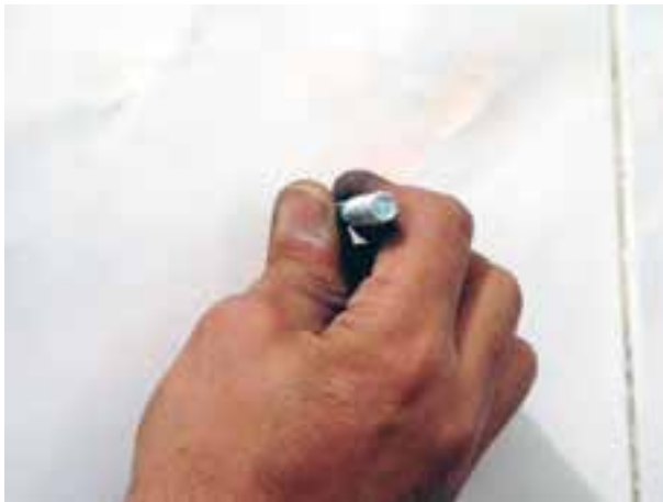
شکل ۳-۴۳- بستن پیچ‌ها در درون رولپلاک‌ها با دست
