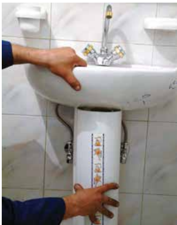
شکل ۳-۵۸- قرار دادن پایه‌ی دست‌شویی در زیر آن
