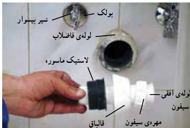
شکل ۳-۵۲- قرار دادن لوله‌ی افقی سیفون در درون مهره‌ی سیفون کاسه و لاستیک ماسوره
