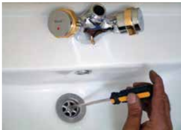
شکل ۳-۴۰ نصب زیراب بر روی دستشویی
