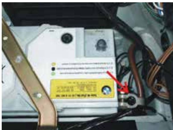
شکل ۳۵-۱- جدا کردن بست اتصال کابل بدنه‌ی باتری
