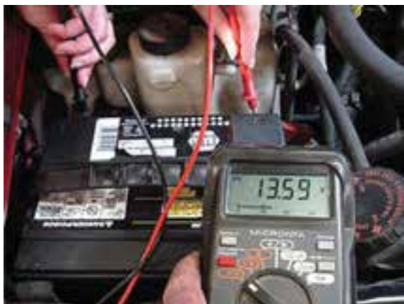
شکل ۵۰-۱ اندازه‌گیری ولتاژ با ولت‌متر دیجیتال
